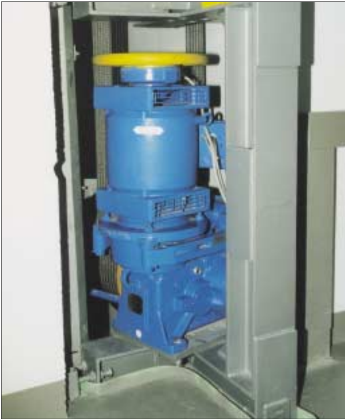
Flender-Aufzugsantrieb für Nutzlast Q = 825 kg und Fahr- geschwindigkeit 1 m/s. Seilabhängung 2:1 Loher-Aufzugsmotor LUGA-132LN-04, 7,5 kW RUPEX-Kupplung Bauart RWB-125 Doppelbackenbremse für T_{\text{Brems}} = 2 \times 80 Nm Schnecken-Stirnradgetriebe CG26-100, i = 18,75 Treibscheibe \varnothing 450
